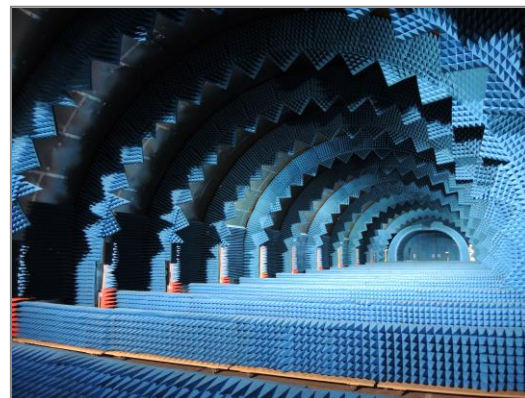
Installation anéchoïque MELUSINE (CEA/Gramat)
