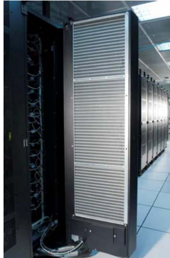
Vue de l'intérieur d'une porte de refroidissement à eau. © P.Stroppa/CEA
