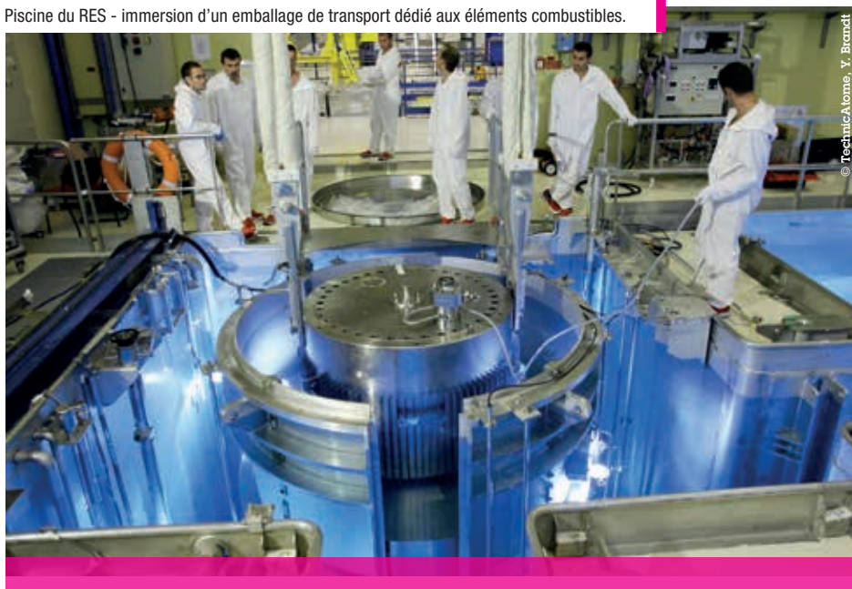
Piscine du RES - immersion d'un emballage de transport dédié aux éléments combustibles.
