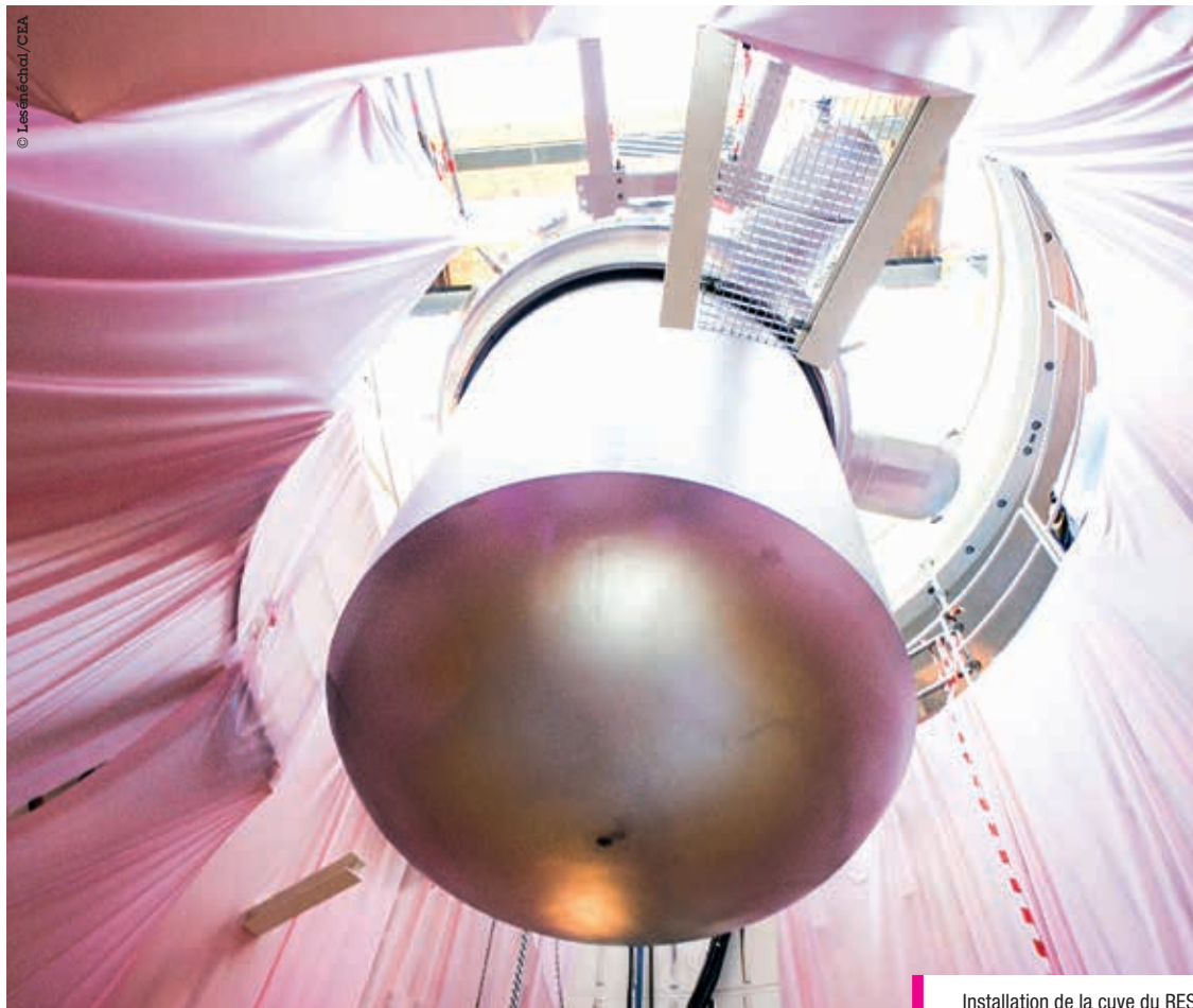
Installation de la cuve du RES.
