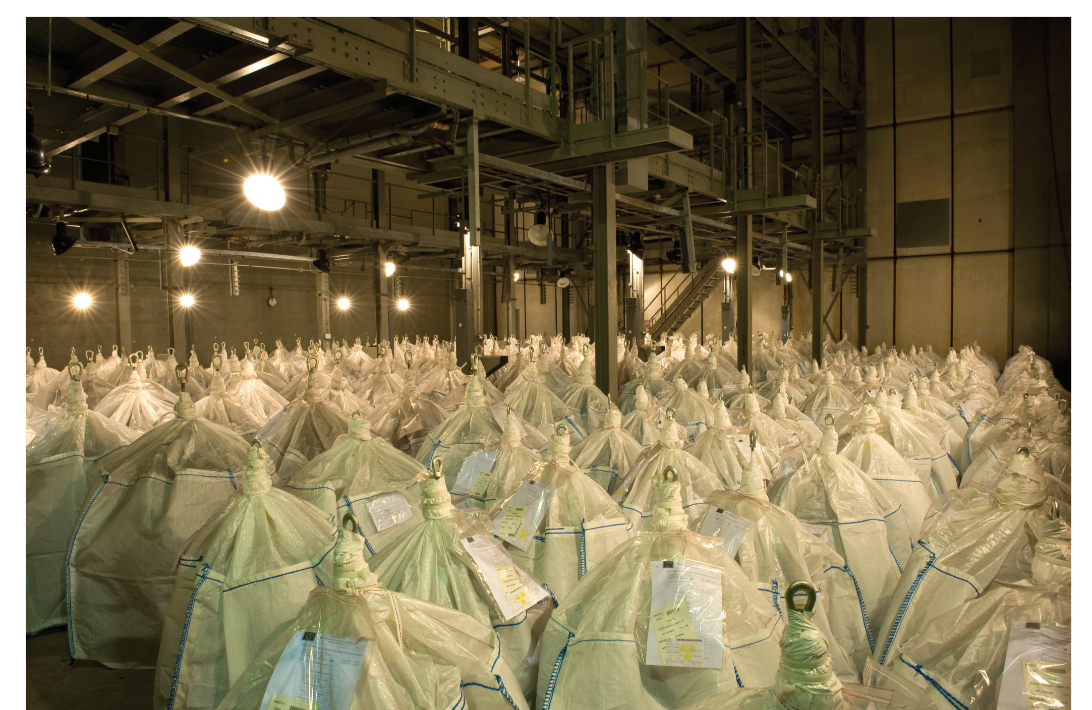
L'usine de Pierrelatte aujourd'hui, à l'issue du programme de démantèlement. Ce dernier a conduit à démonter et broyer 4 000 diffuseurs, 1 300 tonnes de barrières de diffusion, 1 200 kms de tuyauteries et a produit 20 000 tonnes de déchets, évacués vers des sites de stockage définitif. (crédits CEA/DAM)
