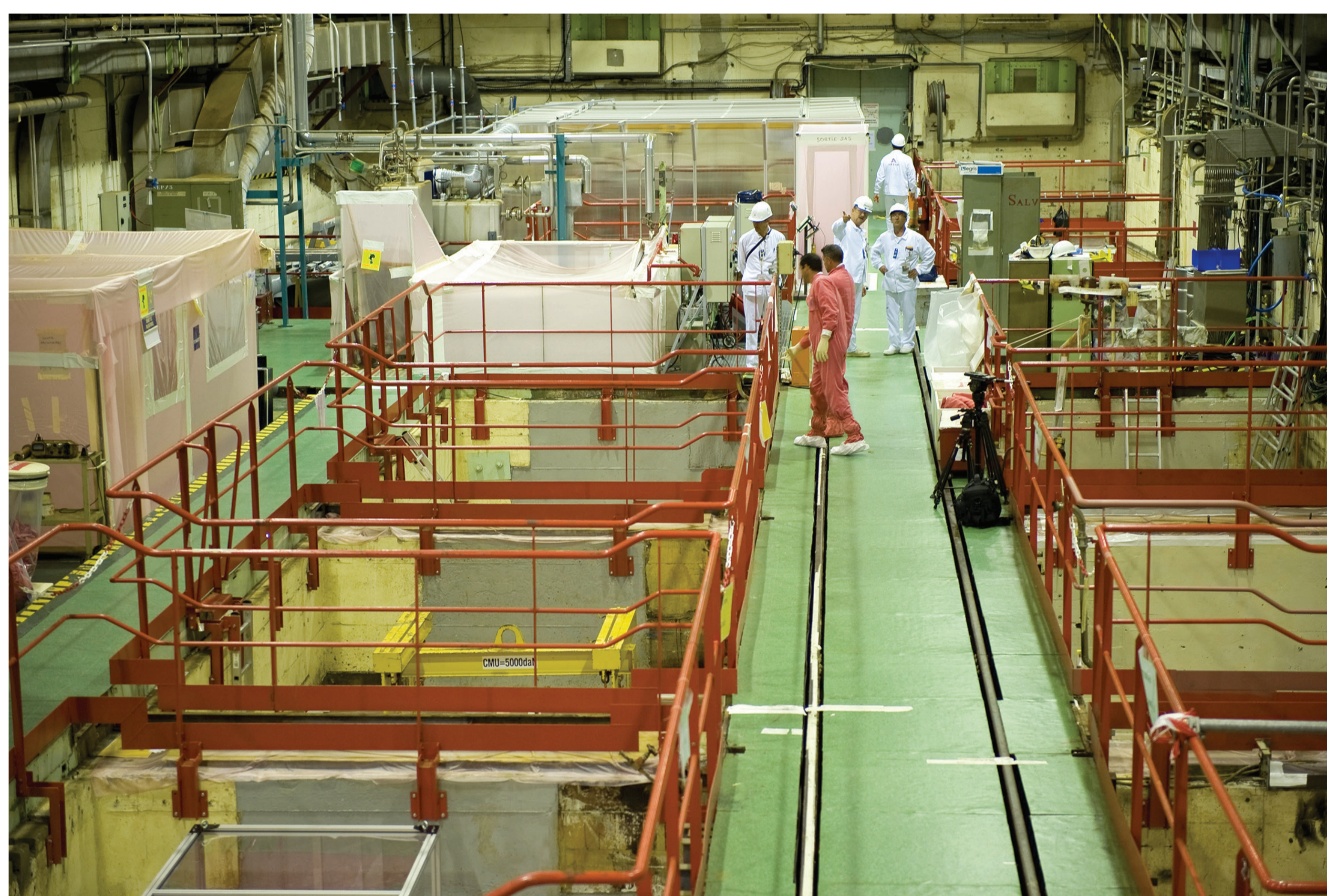
Opérations de démantèlement de l'usine de retraitement du combustible de Marcoule (crédits CEA/DAM)
