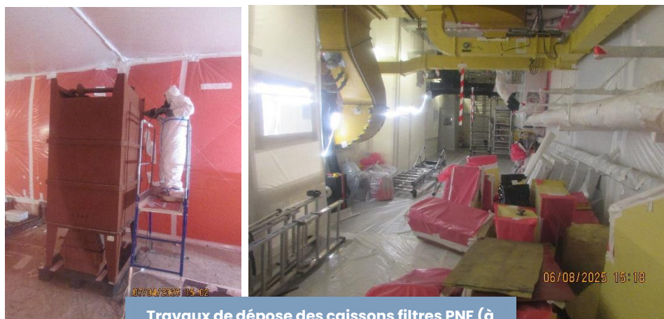
Travaux de dépose des caissons filtres PNF (à gauche) et de dépose des gaines de ventilation des cellules 7 et 8 (à droite)
